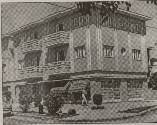
El edificio de Goicurúa y O'Farrill, tal como se veía en 1958.
